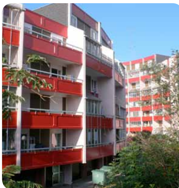
Les Balcons de Malzéville, ensemble de logements sociaux construits après le premier choc pétrolier et objet d'une réflexion énergétique expérimentale.
